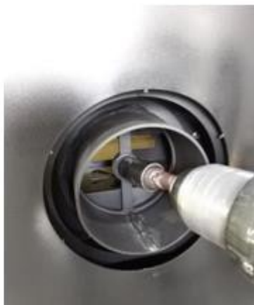
Uchycení přívodu vzduchu šroubem M8
