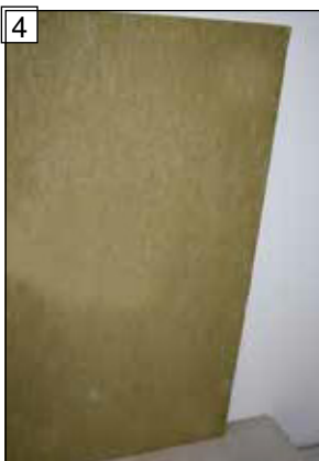
Spodní desku s drážkou sady speciální izolace KINGFIRE na boční stěnu, upevněte na vnitřní stěně.
