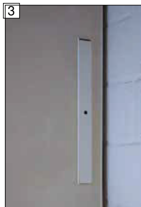
3 Pohled na ochrannou svorku pro montážní skříňku – zabudovanou v závodu – proti znečištění v případě zdokonalení na stavbě (omítka, špachtlování, malířské práce).
