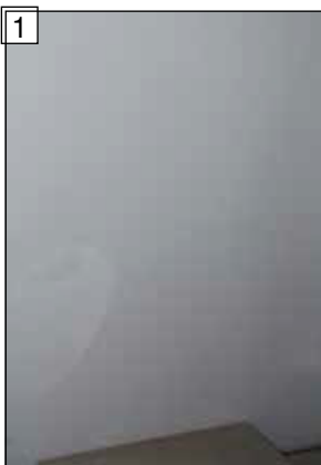
Pohled před začátkem montáže.
