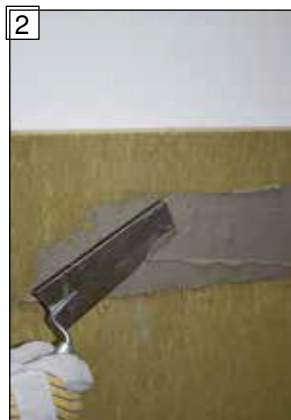
Speciální izolace KINGFIRE na boční stěnu možné podle výběru na vnitřní stěnu na stavbě přilepit nebo alternativně ...
