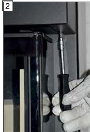
2 Povolte boční fixační šrouby čelního obložení.
