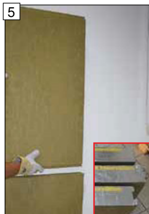
Desku s dvojitým perem zasuňte do desky s drážkou a ...
