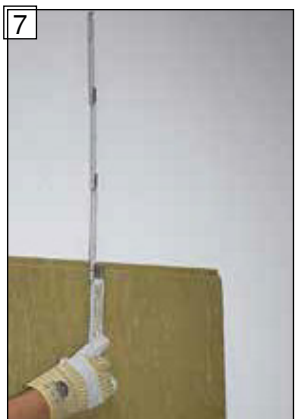
Zjistěte rozměr rozdílu vůči stropu na stavbě.
