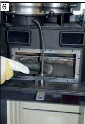
6 Očistěte rozvod přiváděného vzduchu, příp. odstraňte cizí tělesa.
