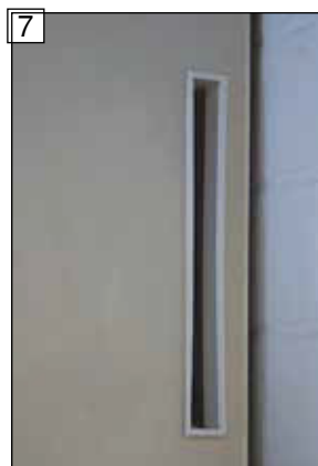
7 Pohled na hotový stav.
