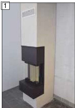
1 Pohled před začátkem montáže.
