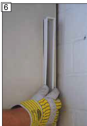
6 Krycí clonu zasuňte do montážní skříňky.
